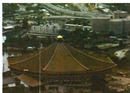
① 竣工時の外観
